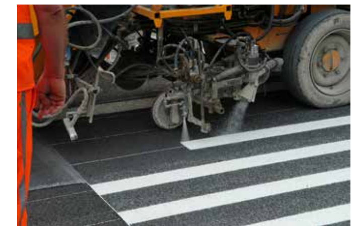
Proefvakken voor wegmarkingen worden in België ingericht onder meer te Baillonville op de N63.
